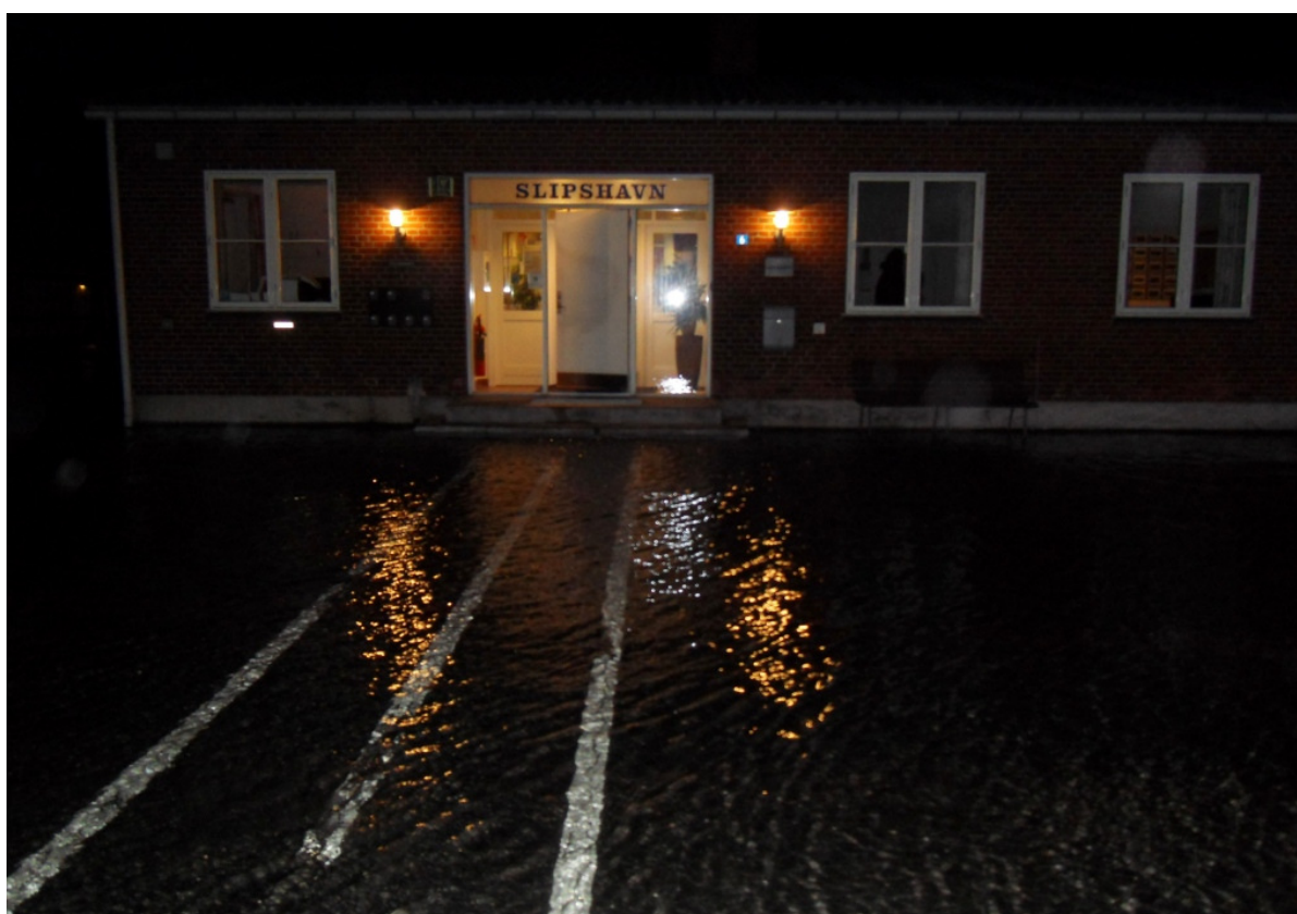
Hovedbygningen med vand helt op til døren. Foto: Ulrik Tertz
