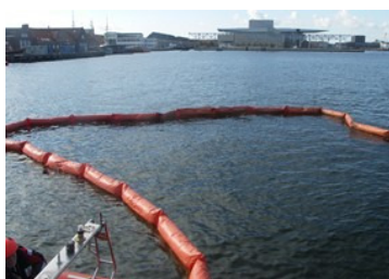
Flydespærringer trækkes ud fra land af Marinehjemmeværnets gummibåde.
