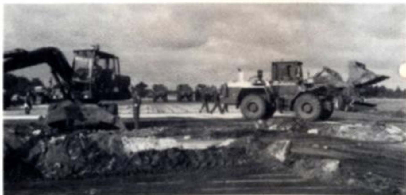
Efter ca. 15 minutter er jord og betonstykker fjernet fra eksplosionsstedet, og i baggrunden er »dumpere« klar til at fylde hullet.
